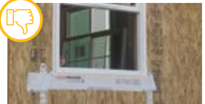
Ventana con tapajunta instalada inapropiadamente.
