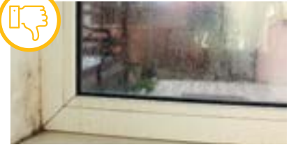
Ventana con condensación por falta de aislamiento.
