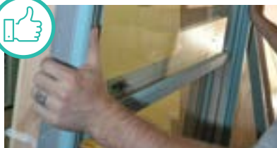
Encaje apropiado de una ventana. Estable y sellado.
