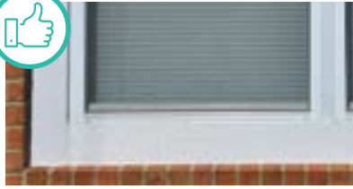
Ventana de doble panel, instalada con tapajuntas adecuado.
